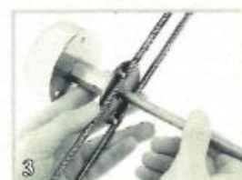
3 Achse durch den Bewehrungshalter schrauben und Erdungseckpunkt befestigen
